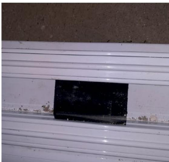
**Foto 5** – Segmento de espuma presente à meia largura do marco nos contatos com topo e base dos montantes centrais.
