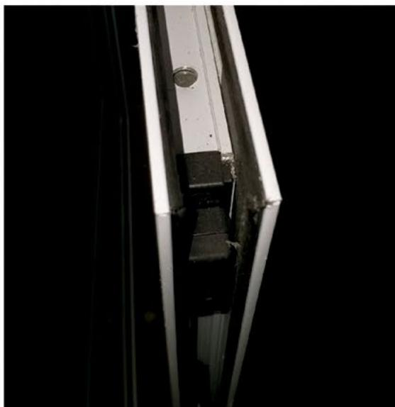
Foto 3 – Tiras de espuma envolvidas por película de composto plástico presentes no montante e travessas da folha.
