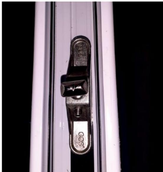
**Foto 6** – Uma das três travas do fecho presente na lateral da folha.
