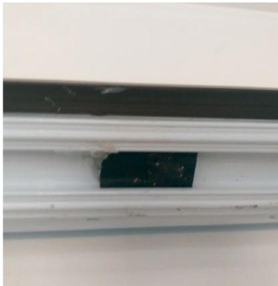
**Foto 5** – Segmento de espuma presente à meia largura do marco nos contatos com topo e base dos montantes centrais.
